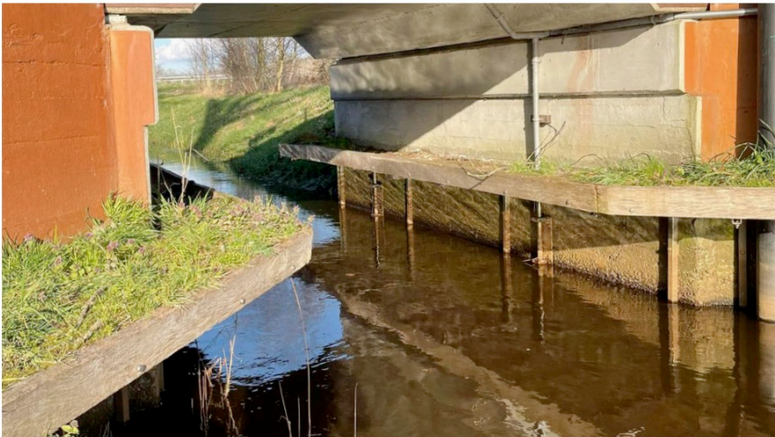
Figuur 18: Voorbeeld van faunapassage onder een brug
