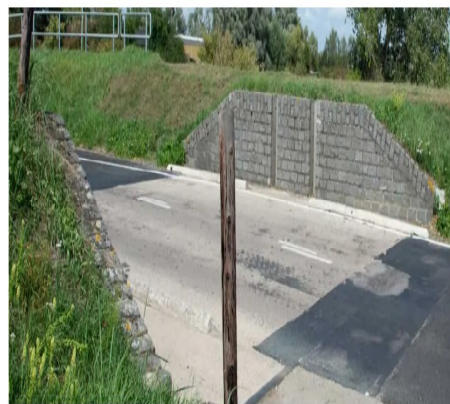
Figuur 17: Coupure in dijklchaam
