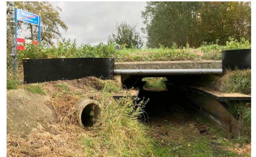
Figuur 53: Voorbeeld van een faunapassage
