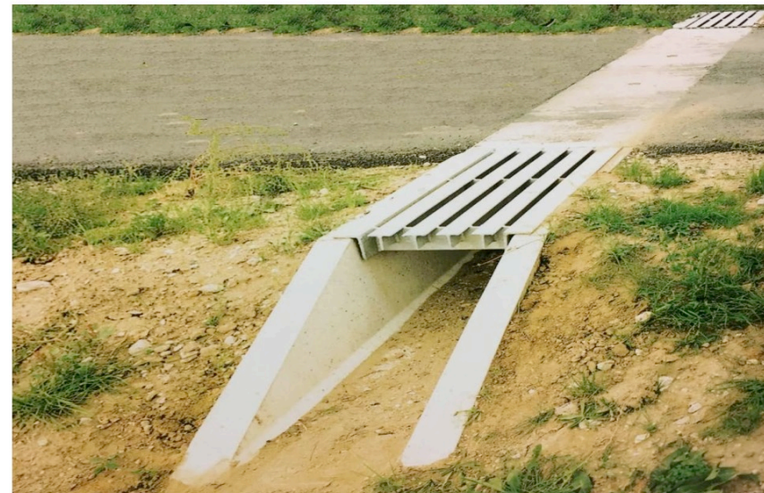
Figuur 52: Voorbeeld van een faunapassage
